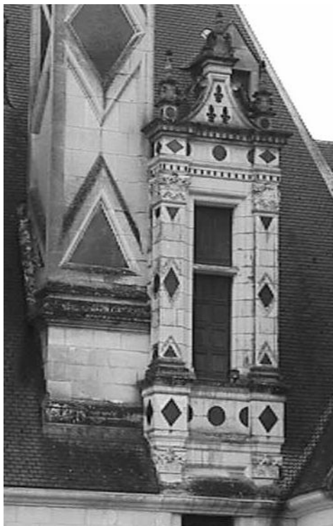
Fig.88 : Lucarne petit modèle ajoutée près de la noue, contre une souche.
