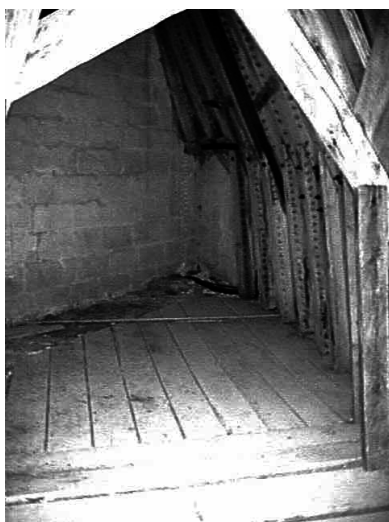
Fig.38 : Espace aujourd'hui inutile de la pièce 3 sous les combles.
