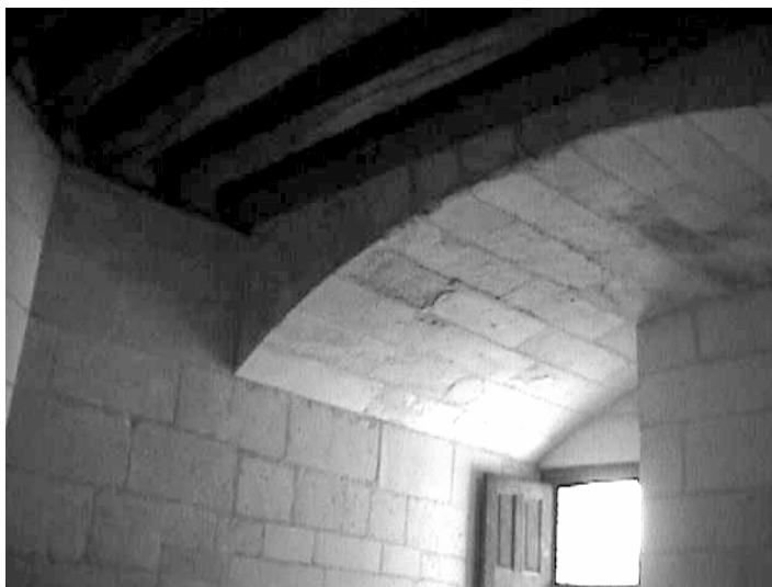
Fig.70 : Détail du couvrement des pièces 1 des logis carrés à l'entresol du second étage.
