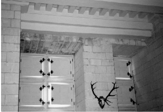
Fig.71 : Couvrement en plate-bande des croisées de la chambre (est, logis carré)
