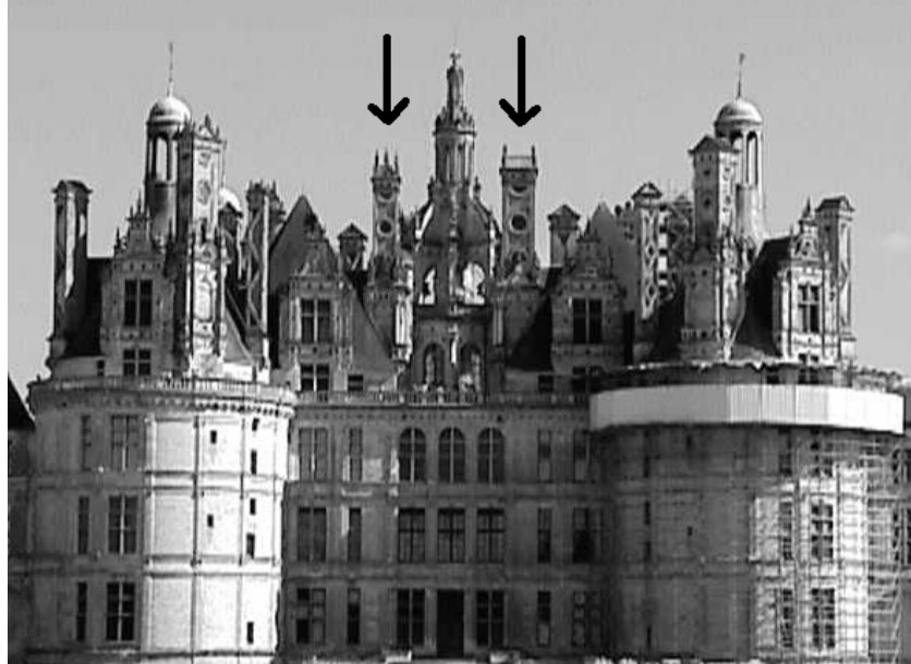
Fig.95 : Façade nord-ouest: de part et d'autre de la tour lanterne, deux grandes souches se font face dans un essai de symétrie.
