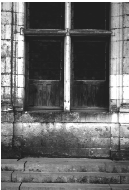
Fig.19 : Baie latérale murée (au sud-ouest comme au nord-est).
