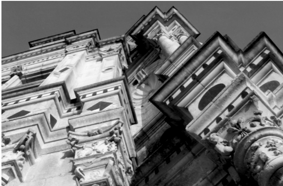
Fig.80 : Sur la tour nord, façade nord-ouest, grande lucarne contre grande souche.
