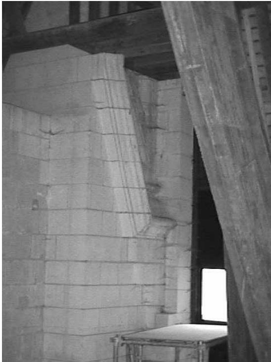
Fig.90 : Solin d'appareil d'une souche à l'origine extérieur se retrouvant dans les combles depuis l'adjonction de lucarnes.
