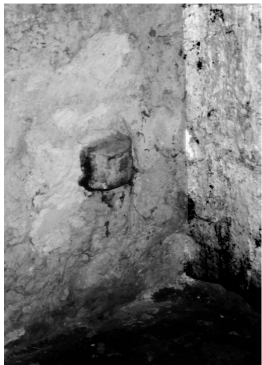
Fig.20 : Détail d'un gond ancien au revers des portes murées.
