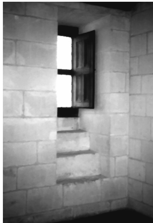
Fig.61 : Vue interne de la deuxième fenêtre dans les pièces 3: certaines présentent un gradin de trois marches.
