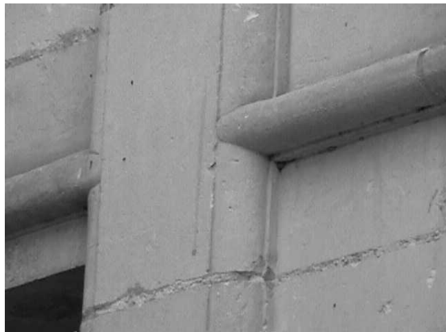
Fig.15 : Croisillon en simple tore (type II).
