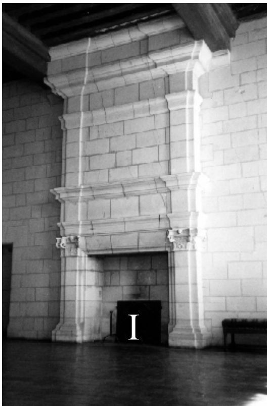
Fig.64 : Les deux types de cheminées des grandes salles : - I à gauche: hotte de cheminée à ressauts au droit des pilastres (la plus répandue). - II à droite: hotte de cheminée droite (rencontrée qu'à partir du second étage).
