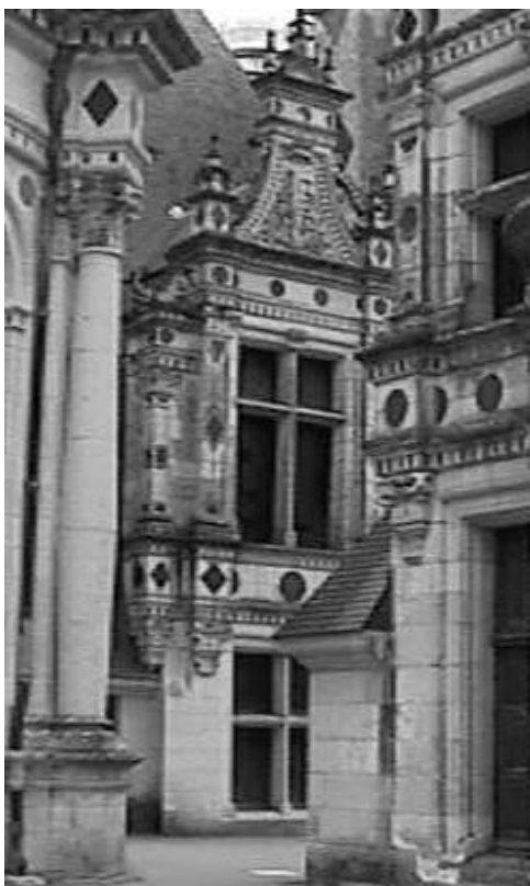
Fig.92 : Vue depuis le bras nord-est de la terrasse, le seul type de grande lucarne sur le pavillon nord.
