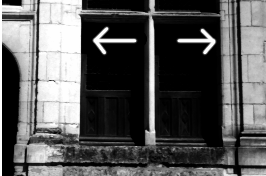
Fig.21 : Assises de pierre correspondant aux anciens sommiers des arcs des portes transformées en fenêtres.
