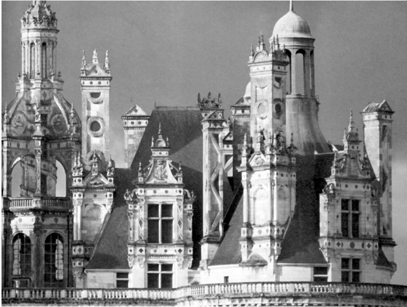
Fig.75 : Vue des parties hautes (ici le quartier est).
