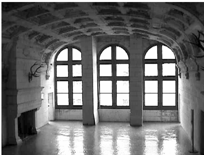
Fig.69 : Vue des voûtes à caissons en anse de panier depuis l'escalier central.
