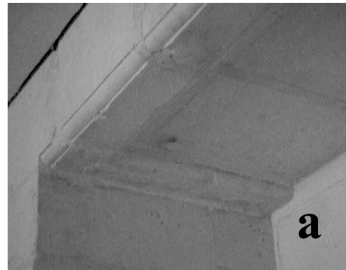
Fig.56 : Vue générale et détail du bandeau clavé à intrados mouluré des pièces 3 des logis carrés, en partie recouvert par la cloison postérieure (a).
