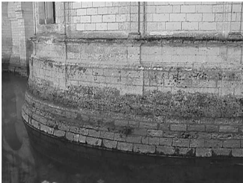
Fig.4 : Base talutée du donjon du côté des douves, façade nord-ouest.
