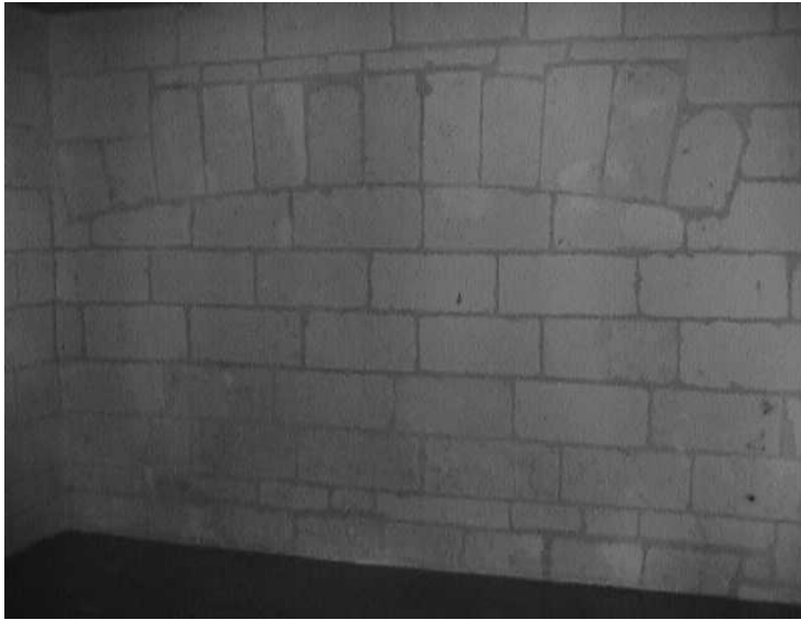
Fig.59 : L'arc de décharge au dessus de l'ouverture de la pièce 3, vu depuis l'entresol de cette pièce. Cet arc n'existe que dans les logis des quartiers sud et est.
