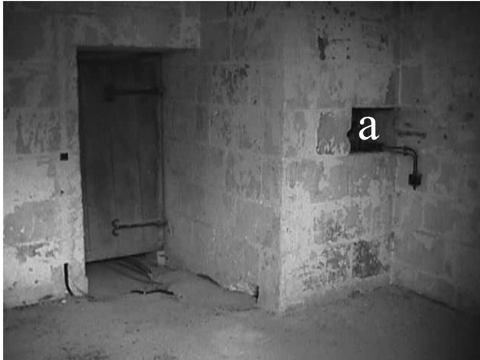
Fig.8 : Passage dans les étages du conduit coffré de descente (a) vers les fosses (ouvert aujourd'hui pour le passage des réseaux...).
