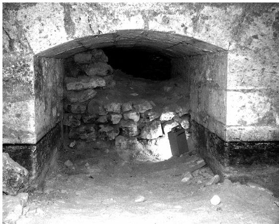
Fig. 6 : Boyau horizontal de communication entre les deux fosses de latrines, en partie bouché à une date encore indéterminée.
