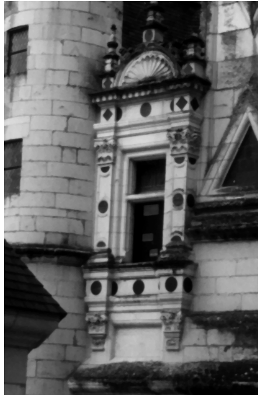
Fig.91 : S'ouvrant sur les bras de la terrasse, un modèle de petite lucarne couronnée d'une coquille.
