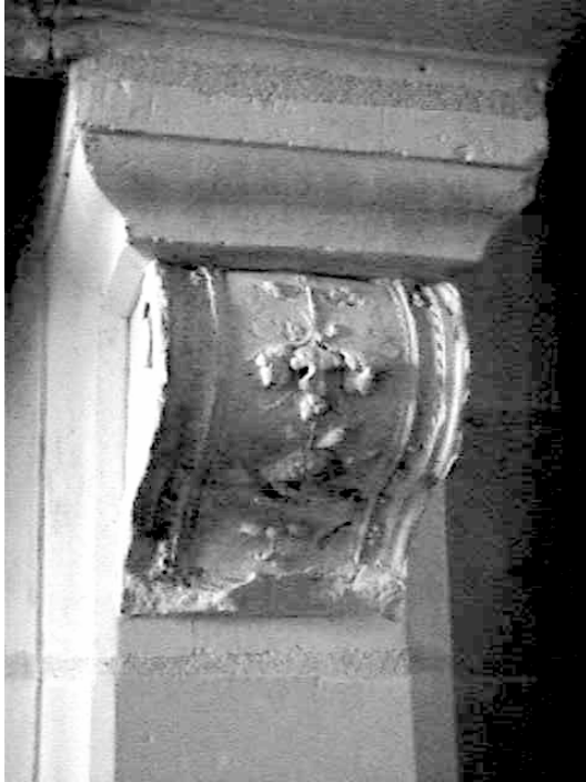
Fig.62 : Une console de cheminée au second étage
