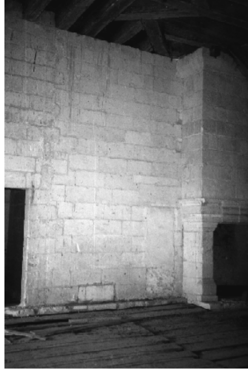
Fig.32 : Rupture dans l'appareillage au droit de l'ancienne cloison de séparation (niveau V, au nord).
