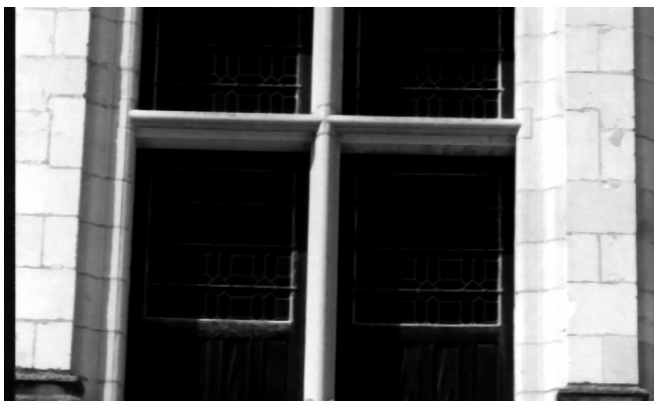
Fig.27 : Deux assises hautes au droit de la traverse, vestiges d'un départ d'arc ancien à la baie centrale au premier étage.
