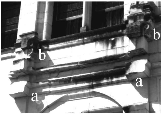
Fig.26 : Assises en retour d'équerre ne montrant pas leur moulures en vis à vis vers l'extérieur (a), ainsi que deux modillons sculptés (b).
