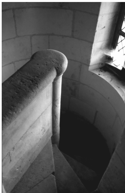
Fig.47 : Petite vis interne à chaque logis, desservant seulement les entresols depuis les pièces notée 3.
