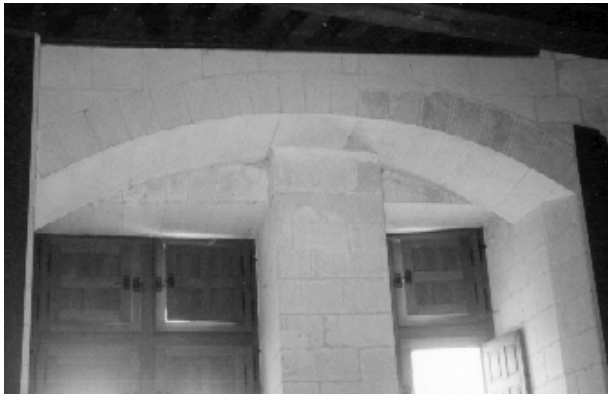
Fig.73 : Grand arc devant le couvrement en plate-bande des croisées de la chambre de tour, à l'est.
