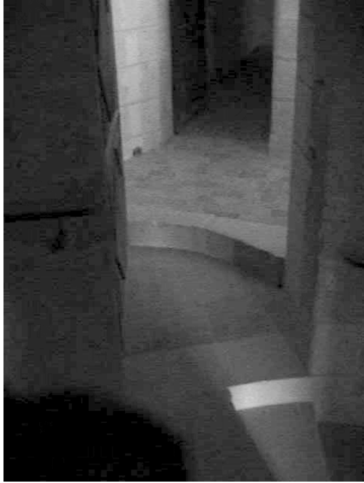
Fig.48 : Palier de desserte des entresols des logis carrés depuis l'escalier de fond-en-comble.
