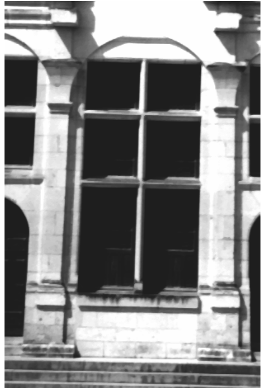
Fig.18 : La baie centrale murée sur la façade sud-est.
