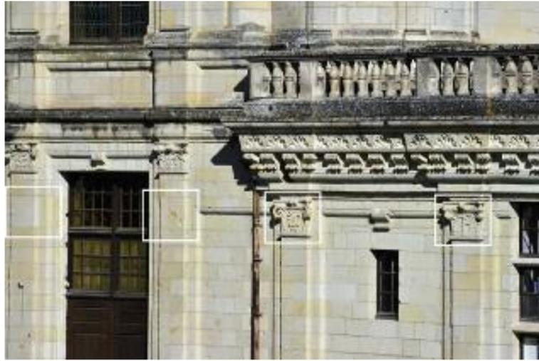
Fig. 12 | Vestiges de chapiteaux sur le rez-de-chaussée de l'aile de la chapelle, qui témoignent du prolongement de l'enceinte basse et de sa corniche avant l'ajout des étages.
